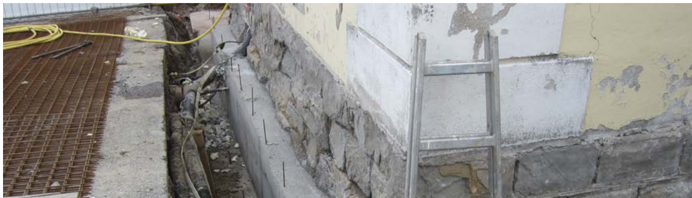
▲ Mauertrockenlegung 2012
